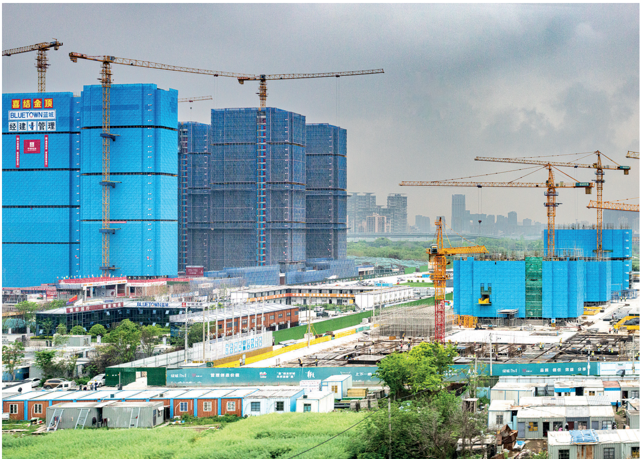
À Hangzhou, les chantiers de bâtiments locatifs hors norme se multiplient.
