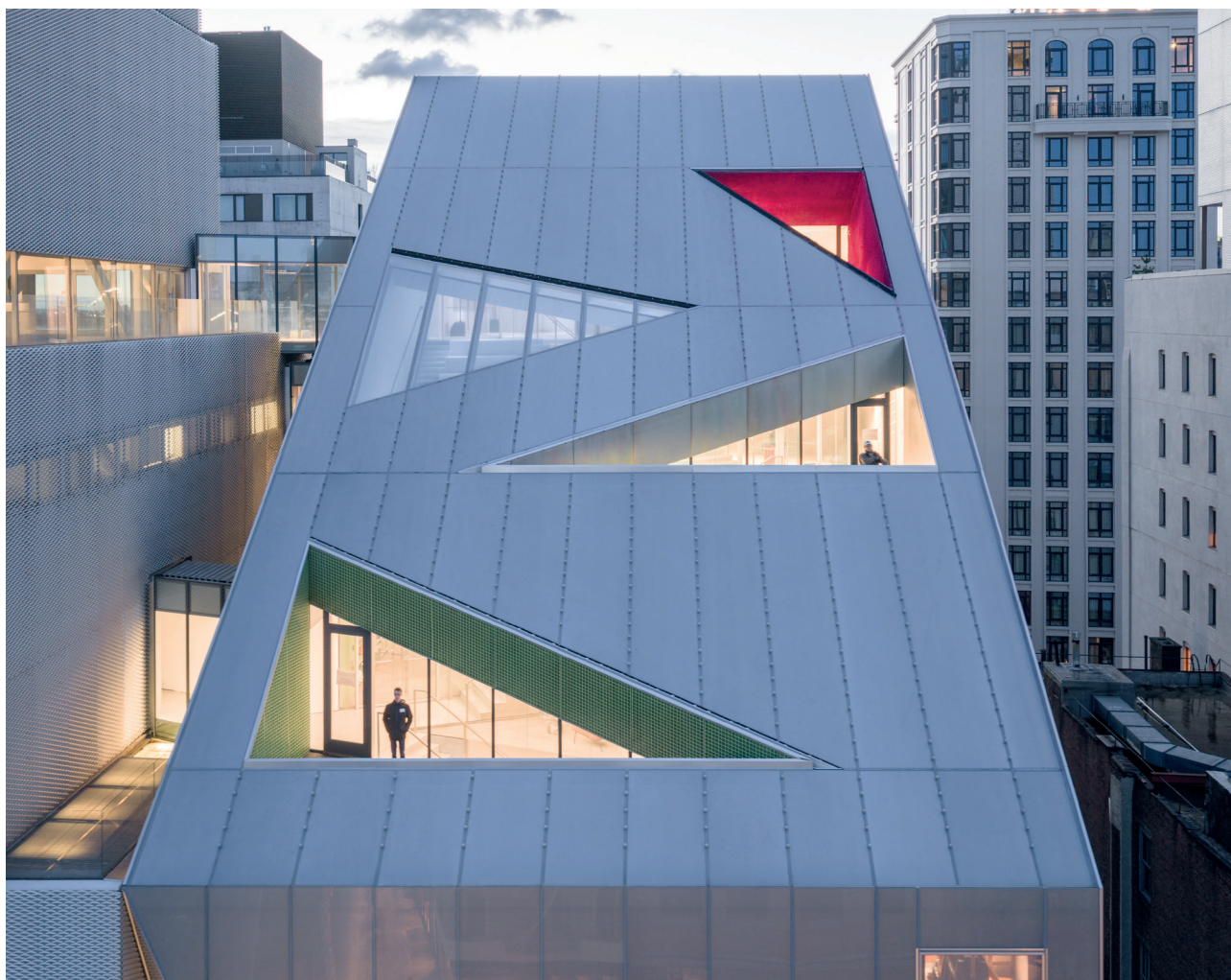
Un détail de la façade de l'extension du New Museum à New York. (Jason O'Rear)
