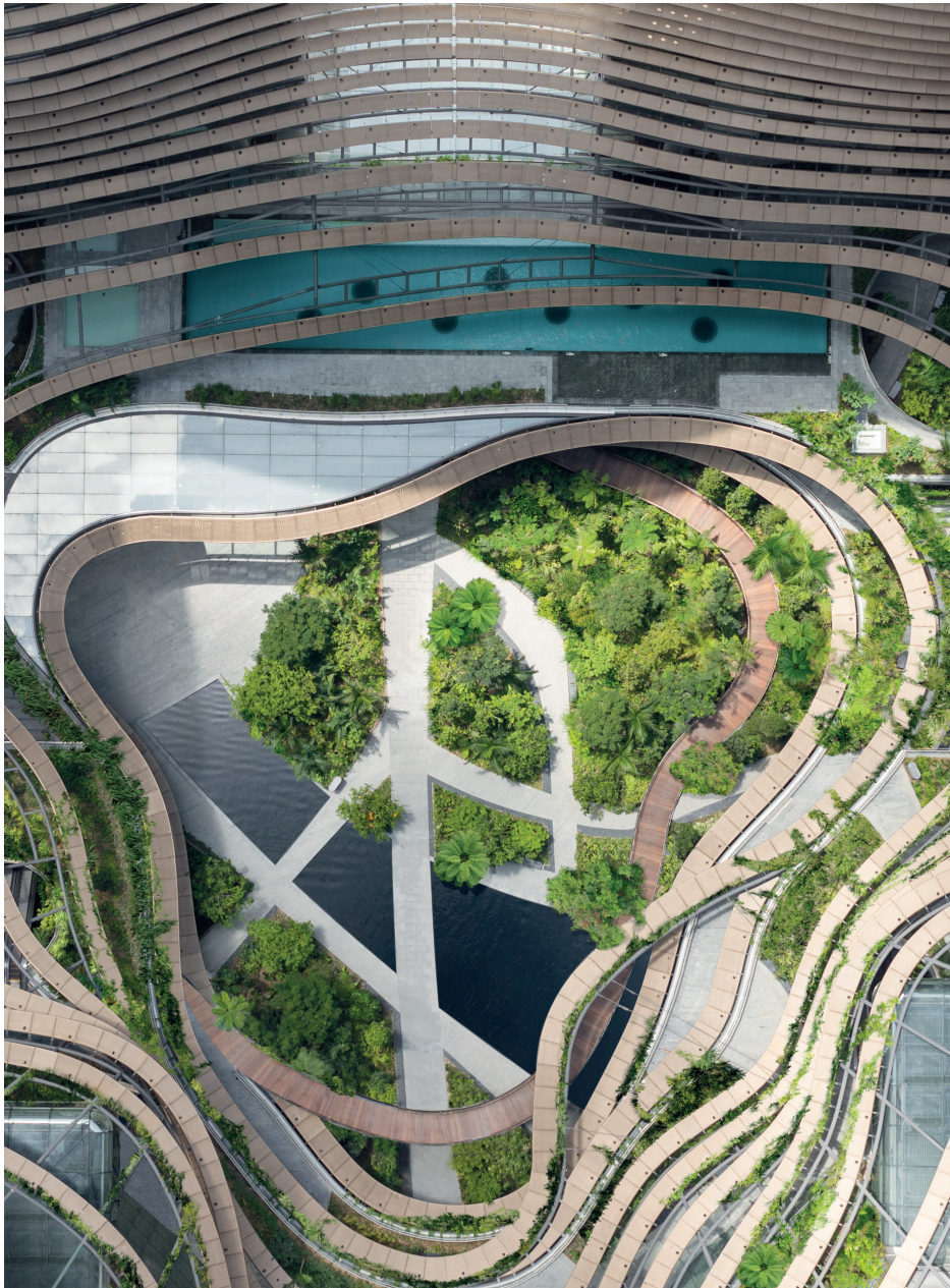
Marina One à Singapour. Un complexe de 400'000 mètres carrés qui associe deux tours de bureaux et deux tours résidentielles autour d'un vaste jardin tropical. (HGEsch)
