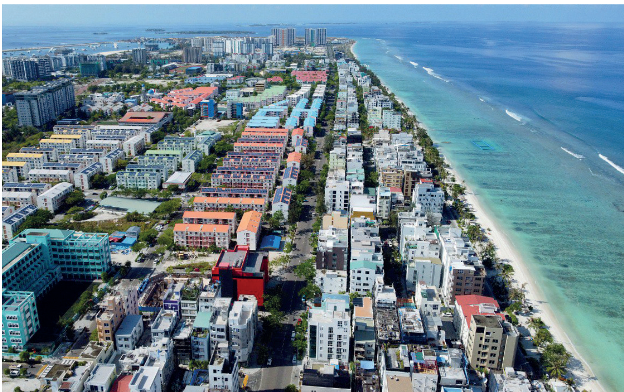
L'île artificielle de Hulhumalé, aux Maldives, a été construite en 2004 pour répondre à la menace posée par l'élévation du niveau de la mer. (DR)
