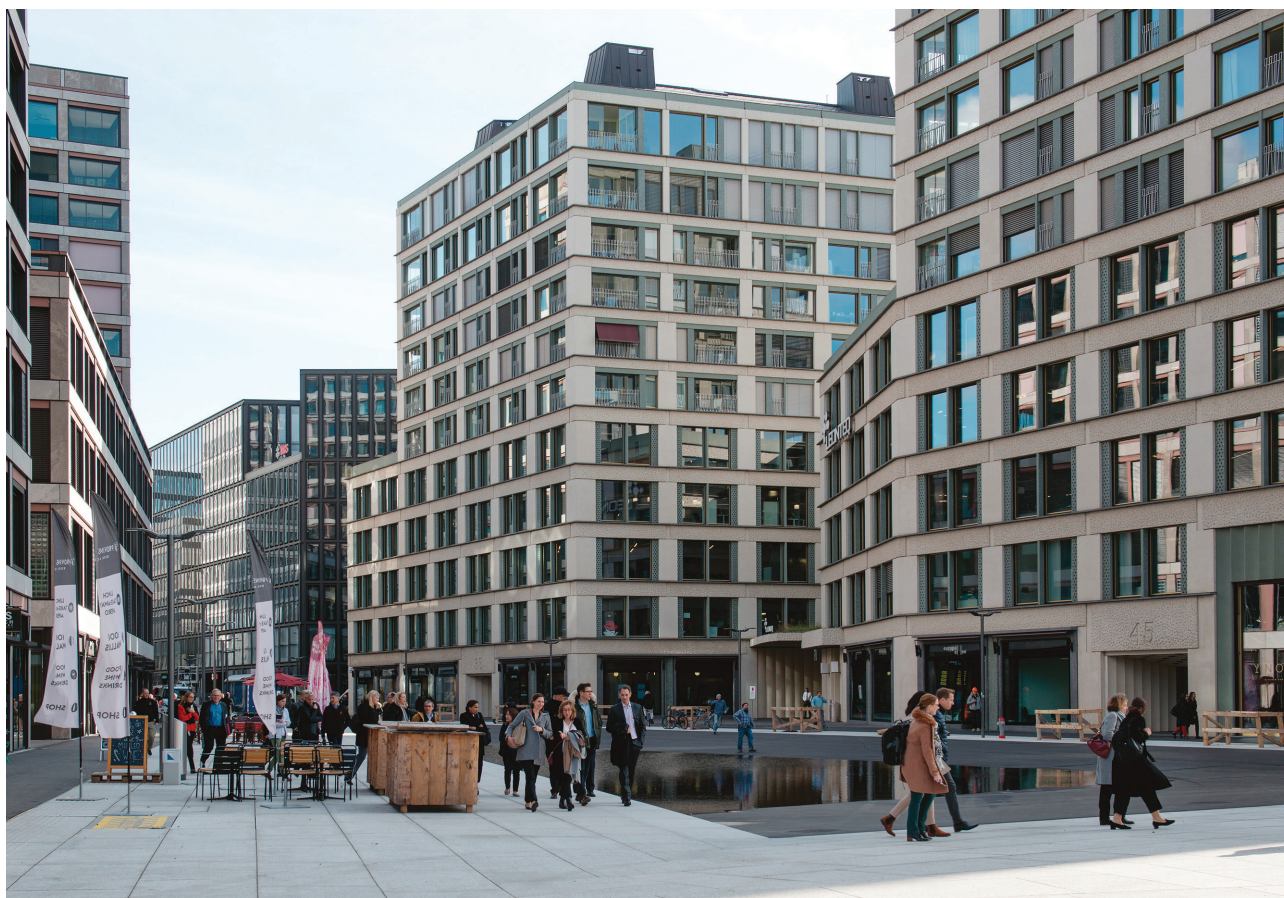
Le quartier Europaallee qui borde les voies CFF à Zurich. L'ex-régie fédérale qui construit à tour de bras est souvent rendue responsable de projets mammoths en panne d'inspiration. (Caruso St John Architects / Bosshard Vaquer Architects)
