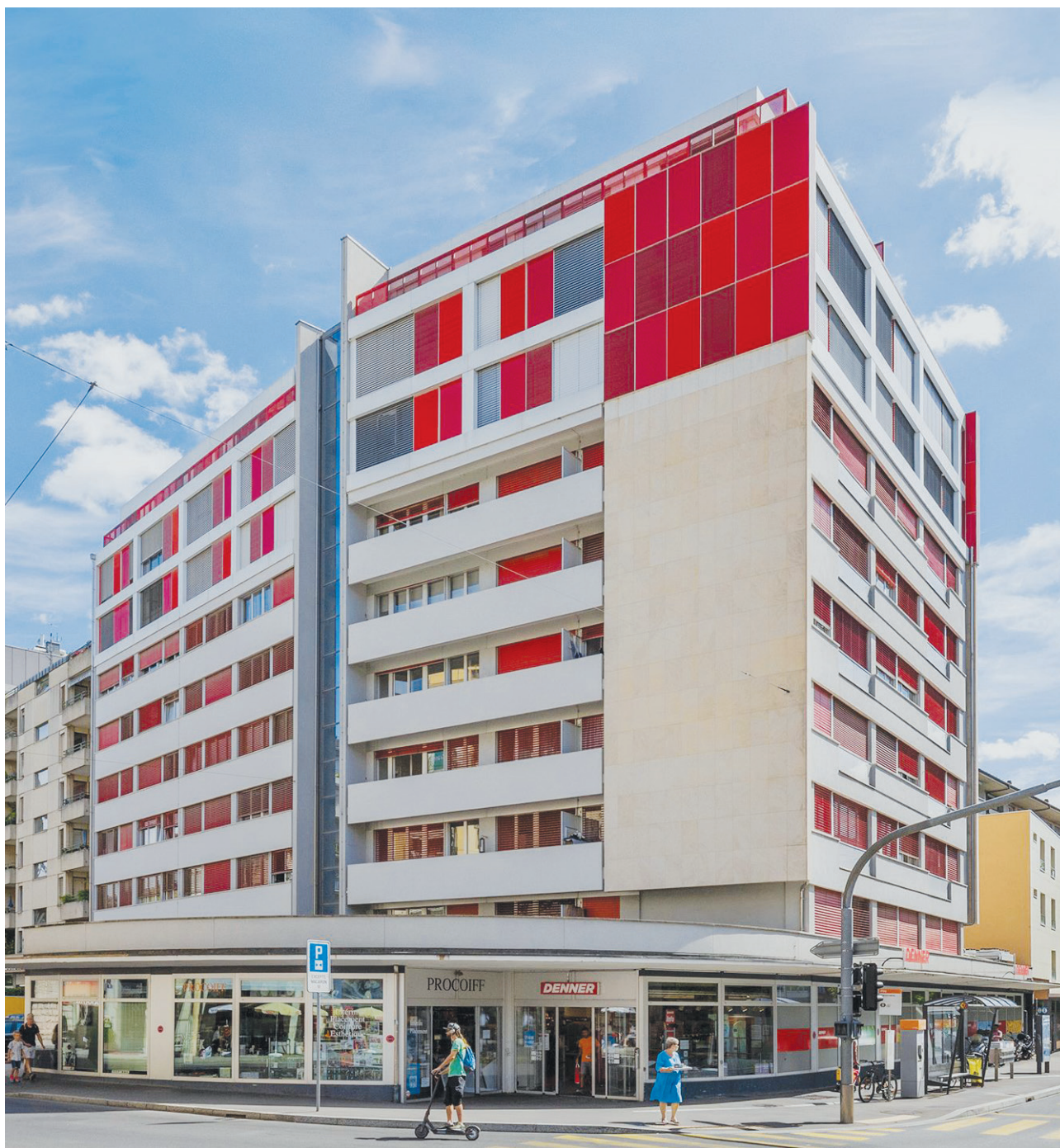
Un exemple de surélévation d'un immeuble de la rue de Vermont à Genève. (DR)
