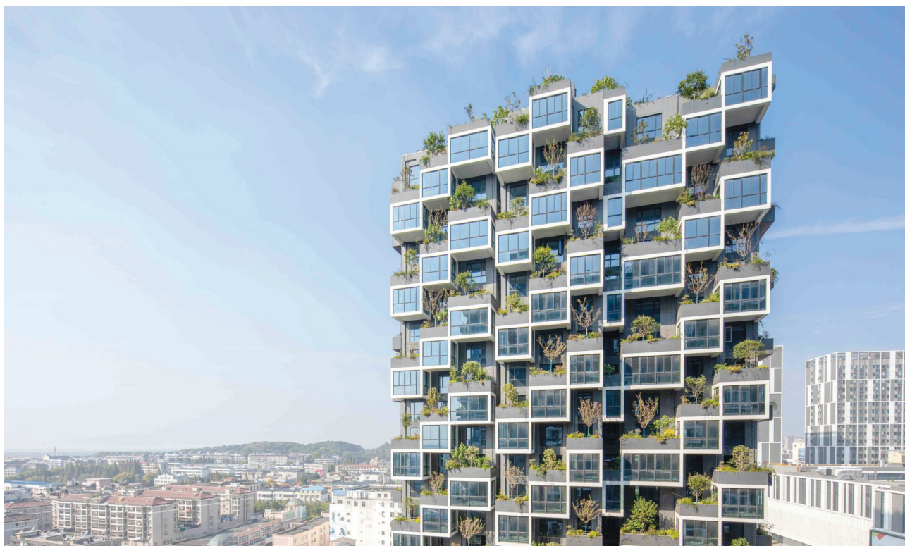
L'immeuble de logement de 80 mètres s'inspire du Bosco Verticale de Milan. (Stefano Boeri Architetti)
