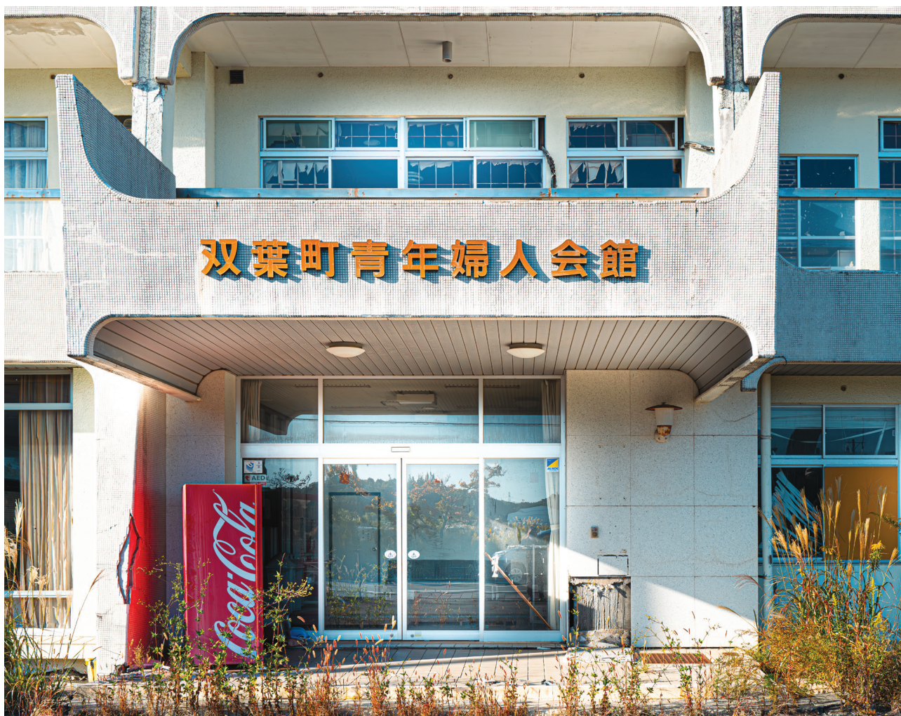
Un hôtel abandonné dans la ville contaminée de Tomioka.
