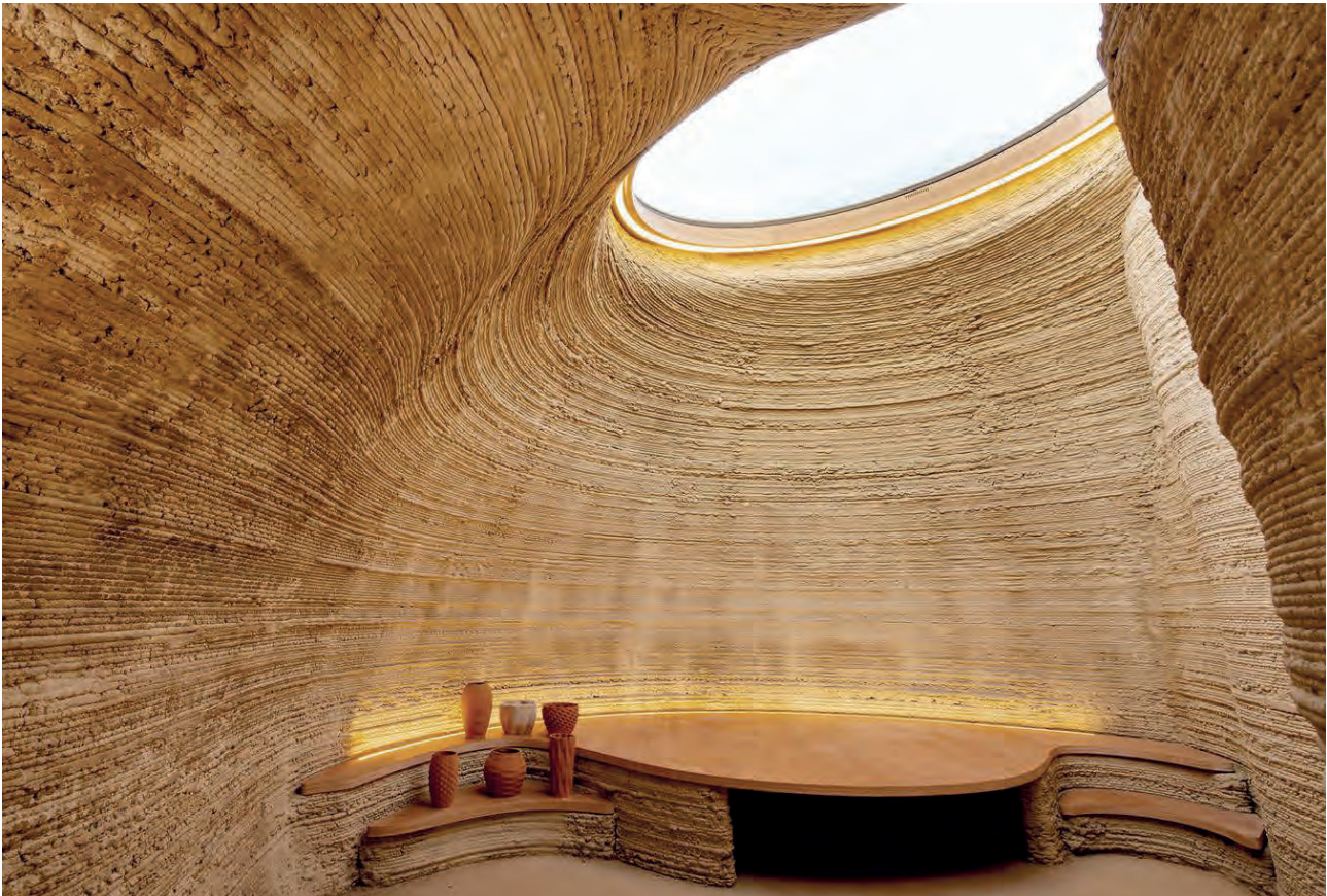
L'intérieur de la villa Tecla construite en argile avec son hublot zénithal. (Mario Cucinella Architects)
