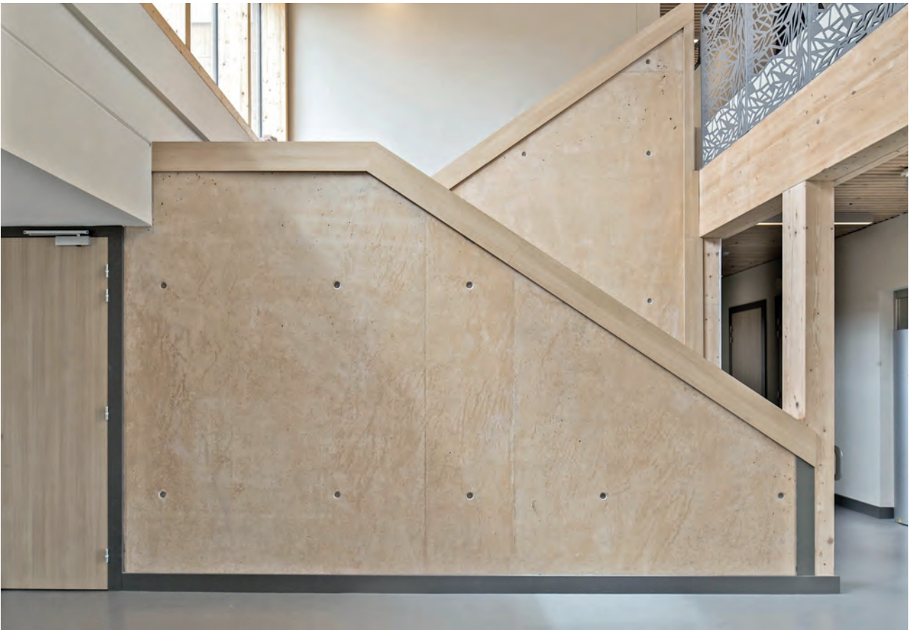
La Maison des associations de Manom en Moselle par le bureau Mil Lieux Architectes. Les murs en béton d'argile apportent une inertie favorable au confort d'été et régulent le taux d'humidité de l'air. (Philippe Ruault)
