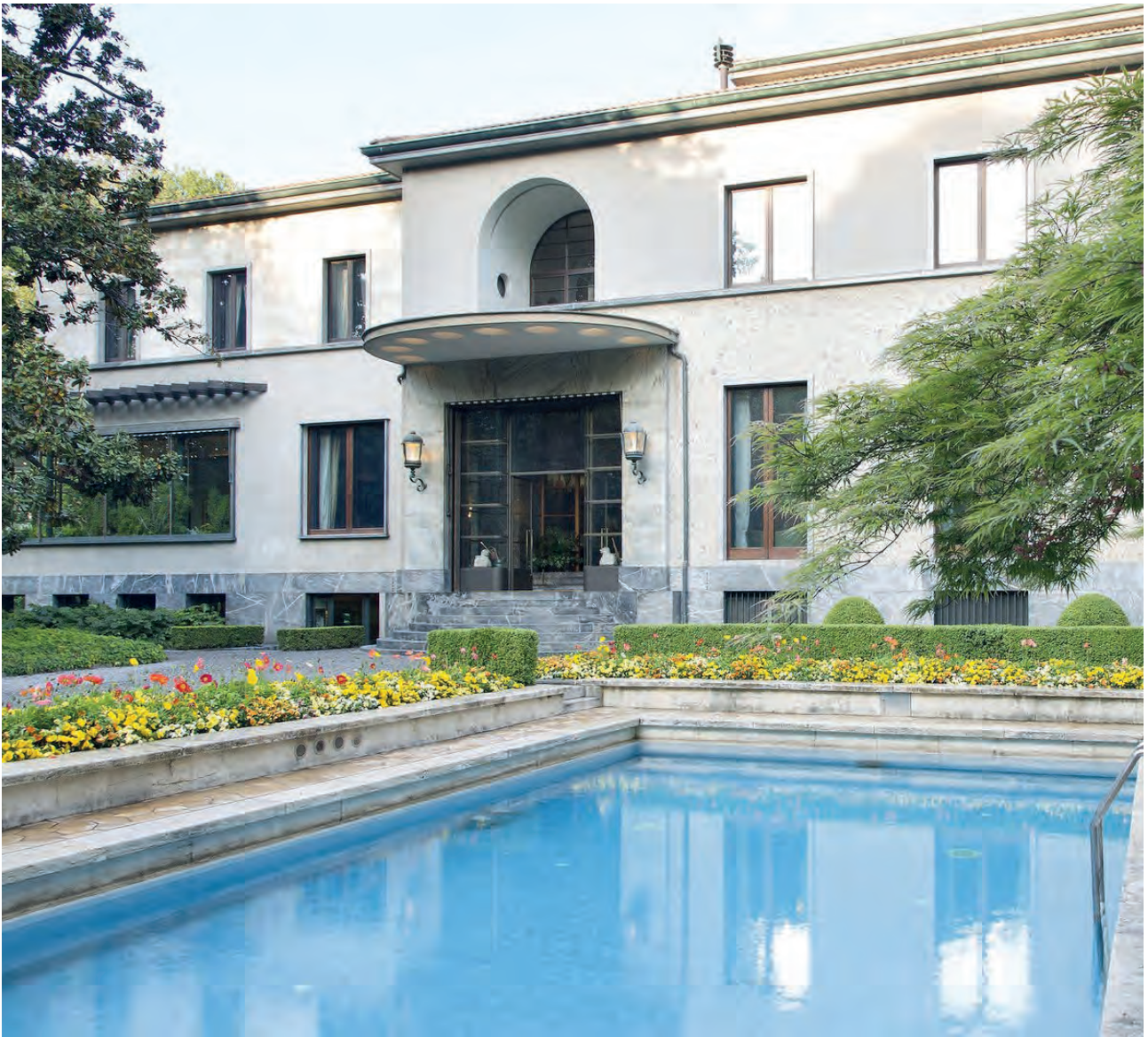
Bâtie entre 1932 et 1935 au cœur de Milan, la Villa Necchi Campiglio fut la première de la ville à être équipée d'une piscine privée. (FAI/Photo: arenaimmagini)
