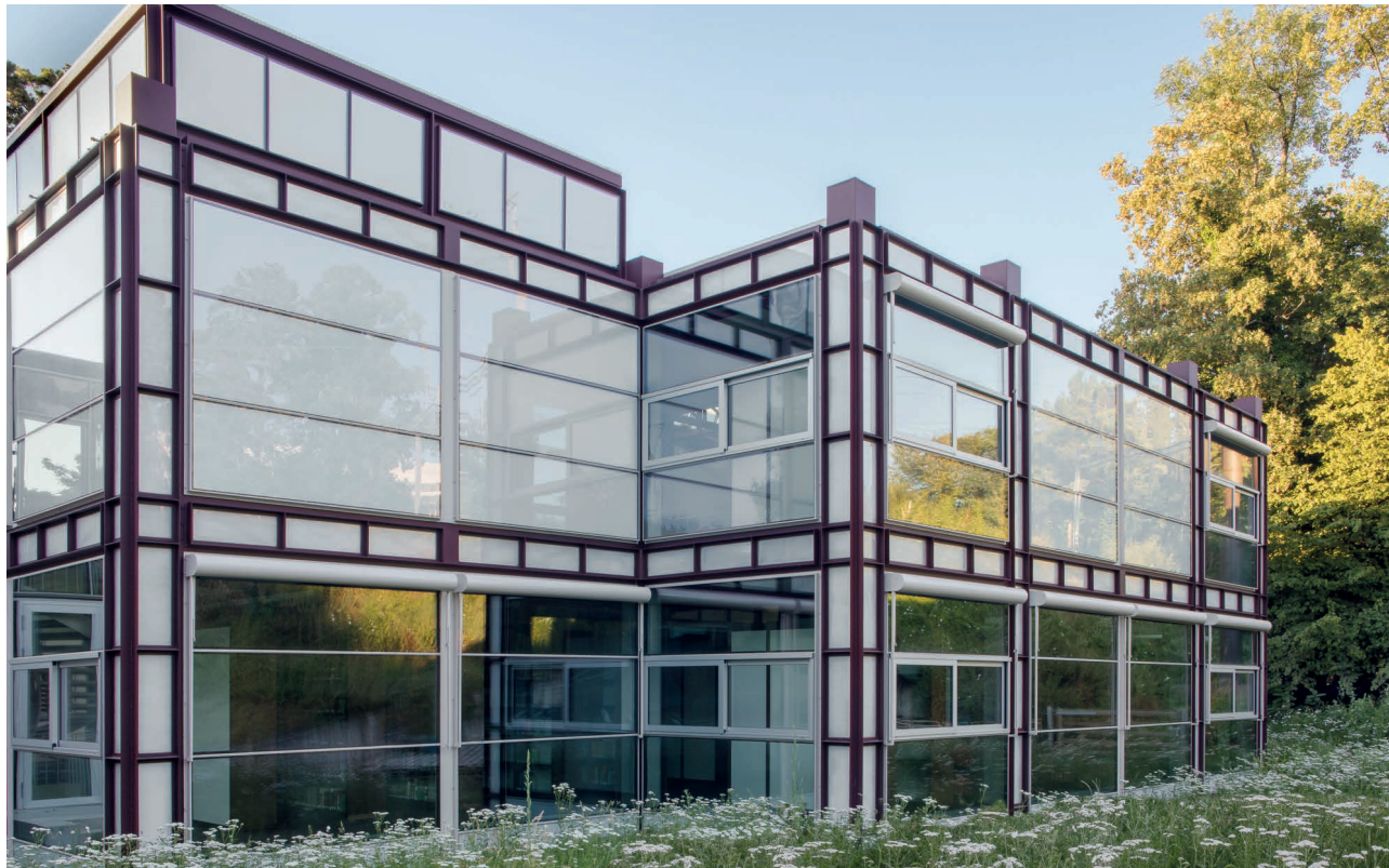
Construits par Jean-Marc Lamunière entre 1967 et 1974, l'institut et la bibliothèque des Conservatoire et Jardin Botaniques de Genève ont été mis aux normes thermiques par Christian Dupraz Architecture Office en 2016. (CJBG © Laura Keller pour Christian Dupraz Architecture Office)
