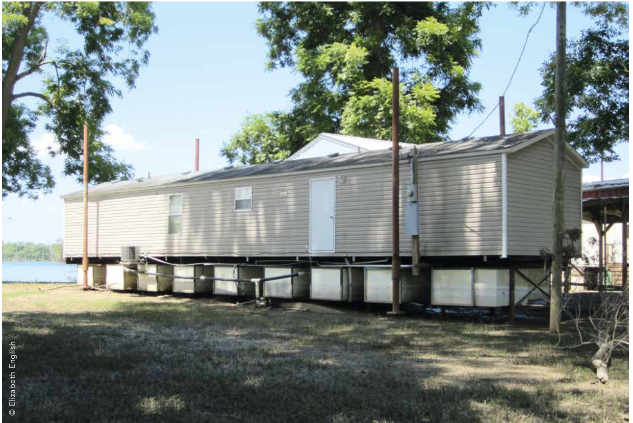
▲ Old River Landing en Louisiane aux États-Unis. Elizabeth English et son équipe préconisent l'utilisation de blocs en polystyrène expansé pour faire flotter des maisons en cas de crue.
