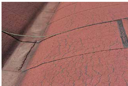
Façonnage et déplacement
