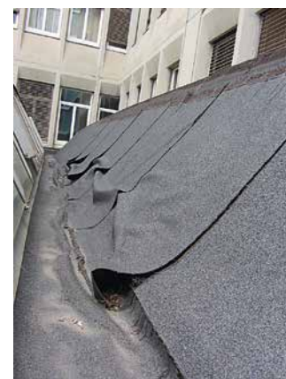
Décollement et glissement
