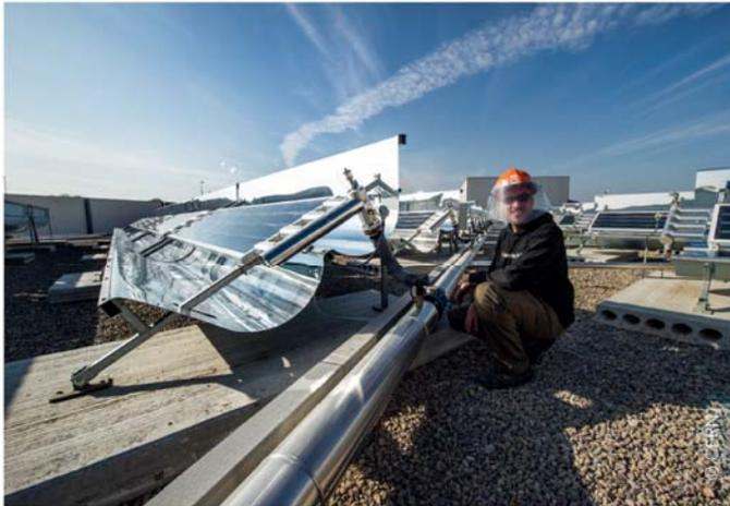
▲ **La technique au quotidien.** Des panneaux solaires plus efficaces ont été développés grâce à la technologie du vide utilisée au CERN. Ils assurent désormais le chauffage et la climatisation de l'aéroport de Genève, même par temps couvert ou sous la neige en hiver.
