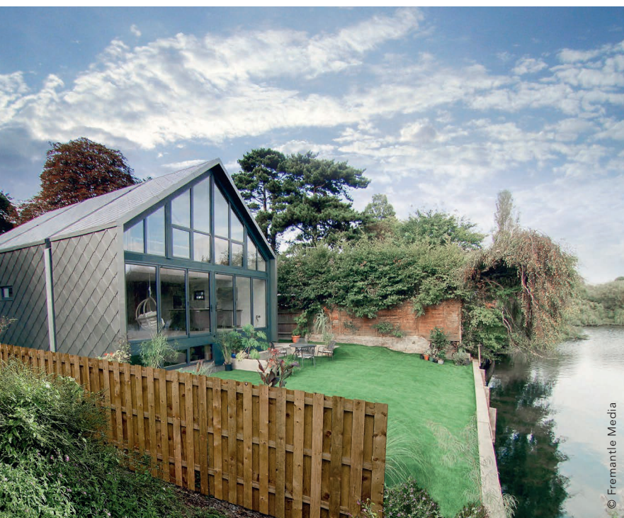
◀ Maison amphibie Formosa à Marlow en Angleterre. Située sur une île dans la Tamise dans le Buckinghamshire, cette maison est conçue pour flotter lors des crues.
