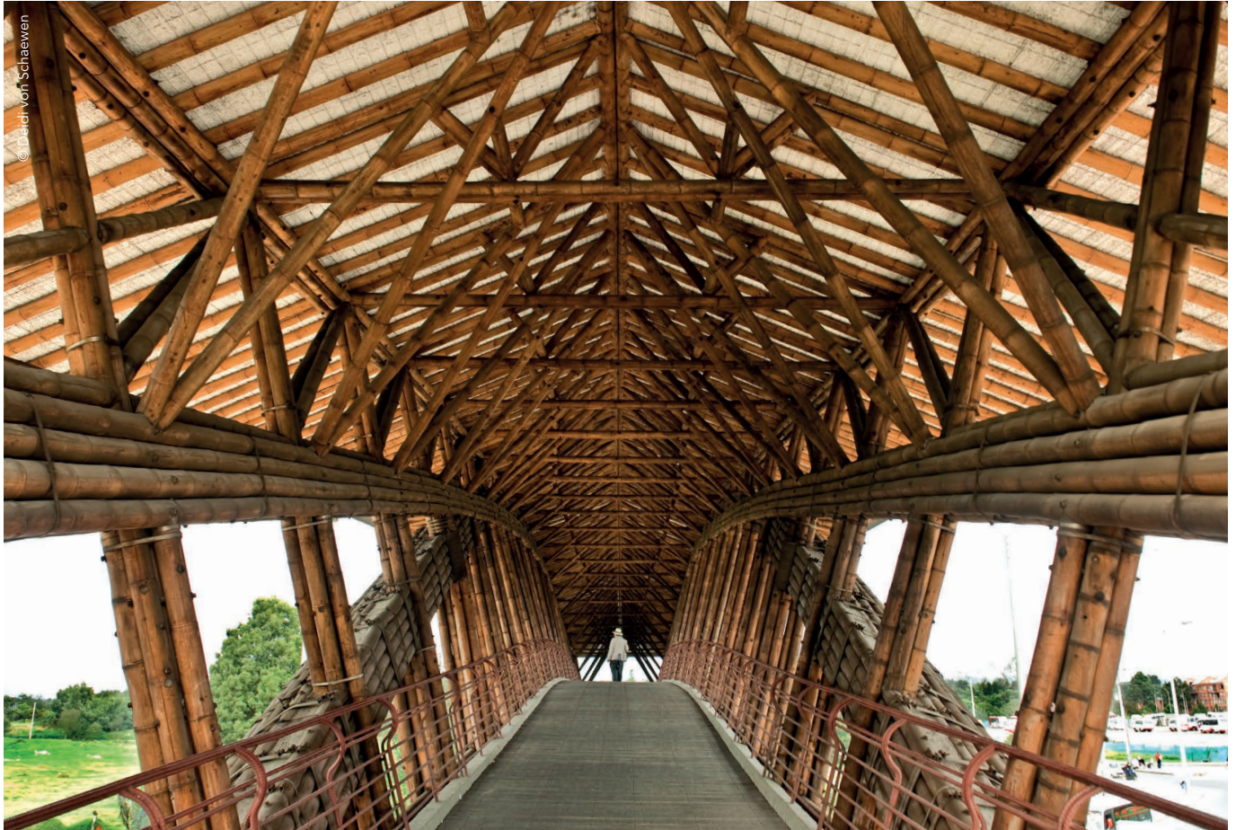
▲ Pont piétonnier Jenny-Garzón à Bogotá. Traversant l'autoroute Bogotá-Medellín, la structure a une portée libre de 45,6 mètres.
