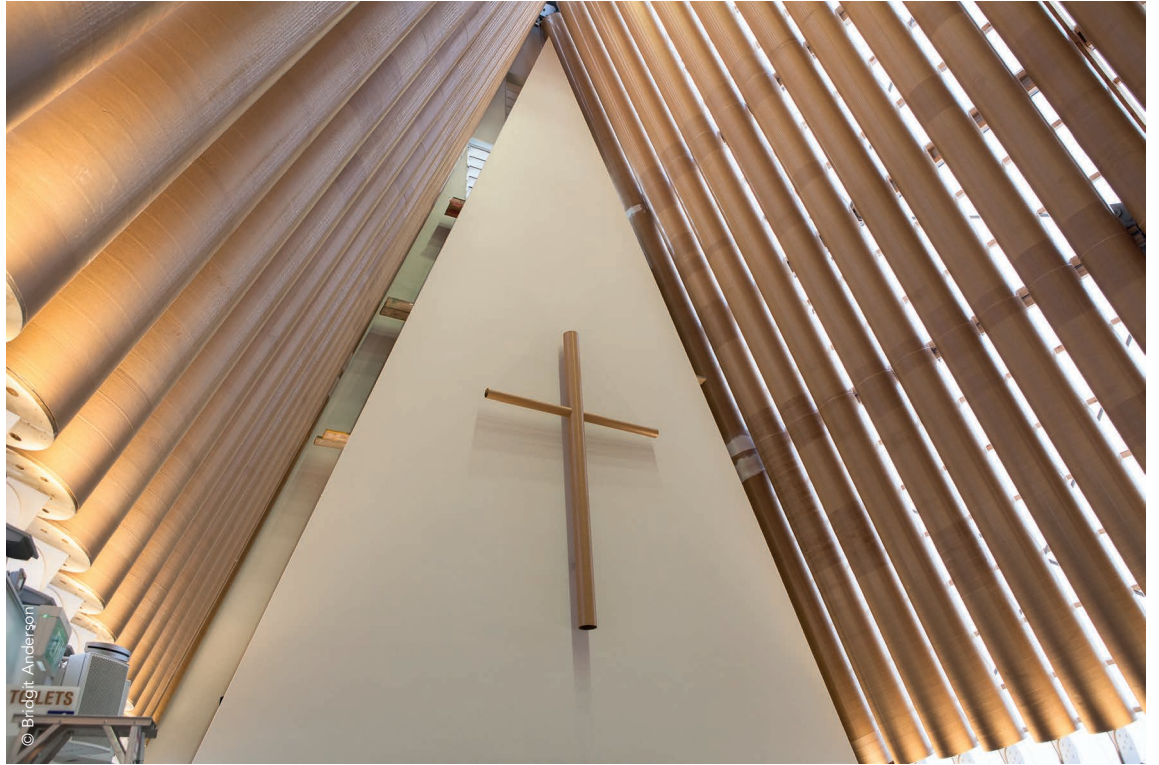
▲ Cardboard Cathedral à Christchurch en Nouvelle-Zélande. Au-dessus de la croix, la structure en tubes de papier du toit est complètement visible, ce qui met un accent sur le caractère éphémère du bâtiment, mais qui ne nuit nullement à sa solennité.
