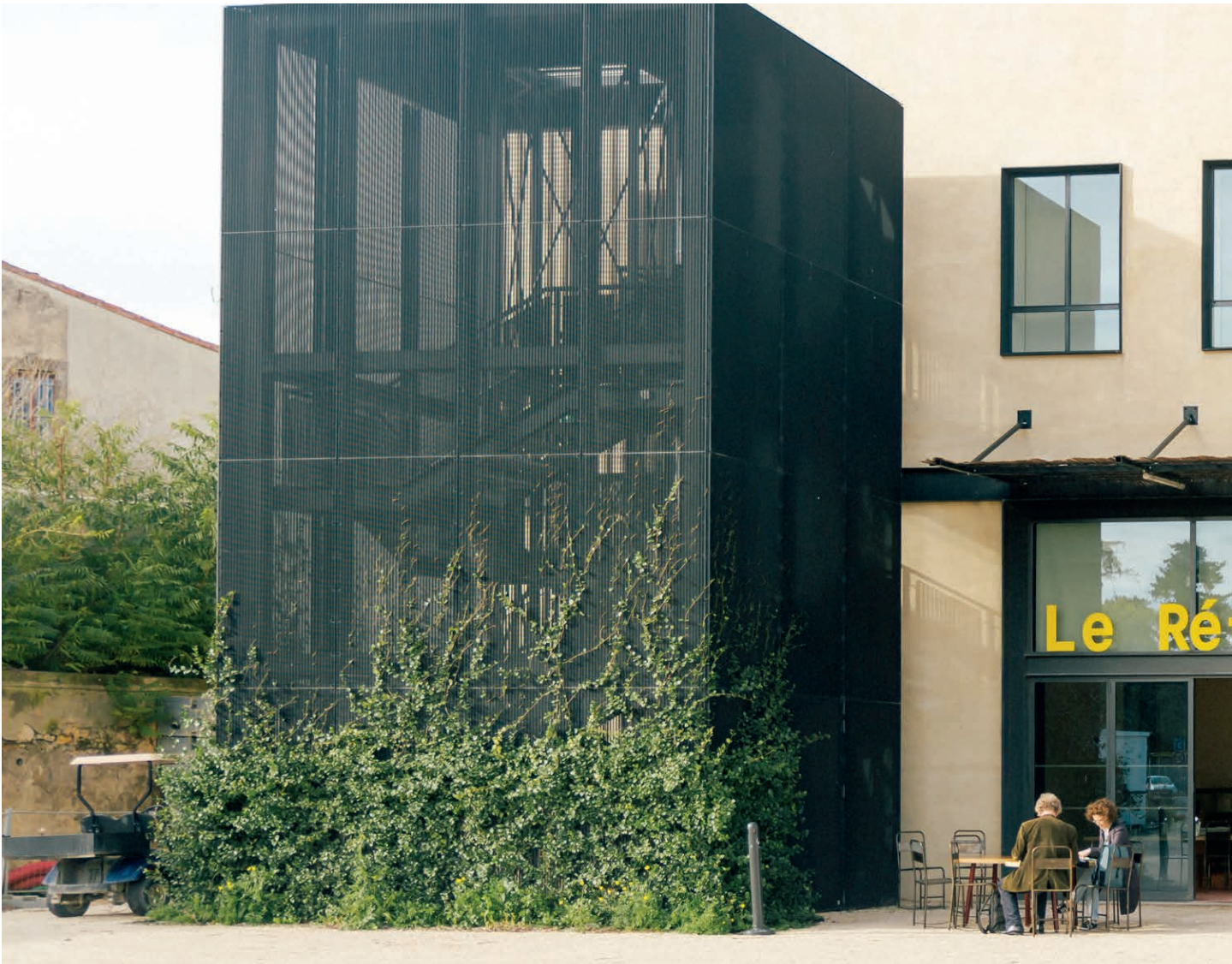
Vue extérieure de La Formation, rénovée par Selldorf Architects en 2018. Luma Arles, Parc des Ateliers , Arles, France.
